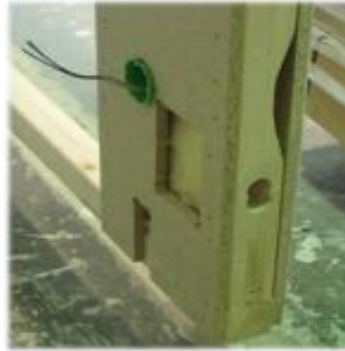
Intégration des réseaux à la fabrication sur la maison Ossature Bois
