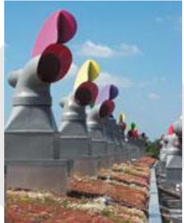
Tour à vent qui s'oriente en fonction du vent
