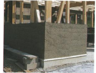
Béton de chanvre monté en murs
