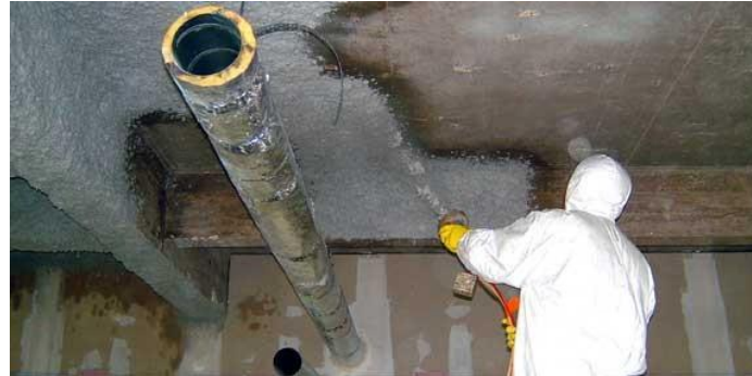
Projection de mousse polyuréthane
