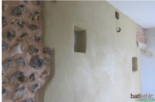
Béton de chanvre projeté, taloché
