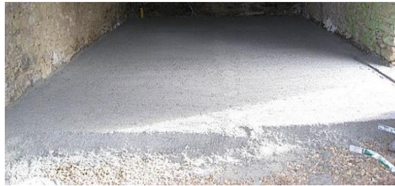
Béton de chanvre sur le sol
