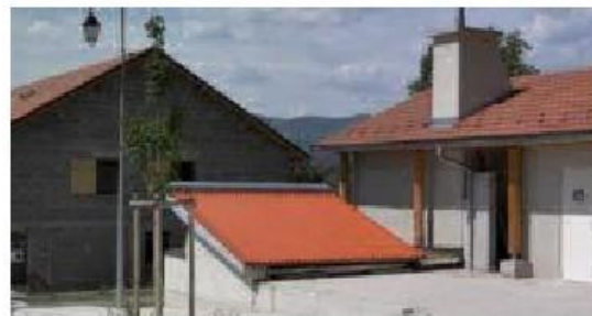
Chaufferie bois La Rivière (38)
