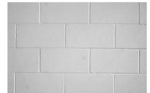
Pour un mur porteur en béton cellulaire de 30 cm d'épaisseur, cette résistance peut atteindre 18 tonnes au mètre linéaire.
