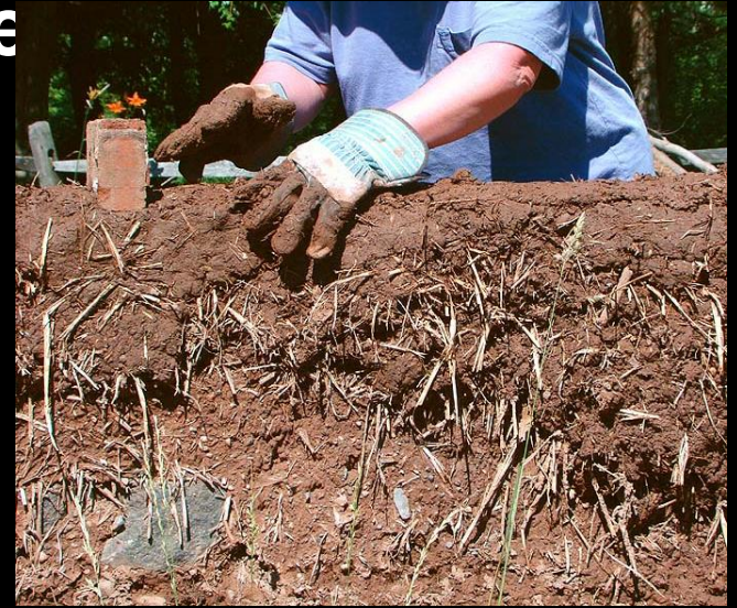
construction de mur en bauge (foto: Wikipedia)
