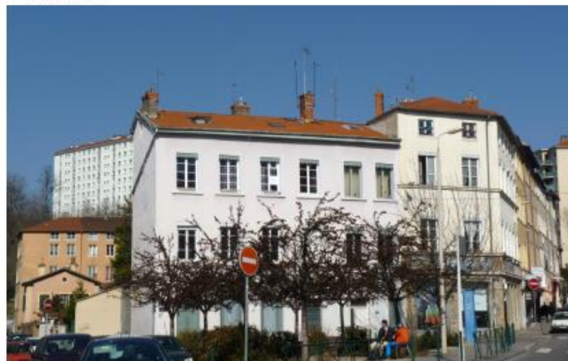
Lyon : Quartier Saint Just, Immeuble en pisé à la jonction de la rue Benoist Mary et de la rue des 4 colonnes © Sébastien MORSEZ, CRATERE
