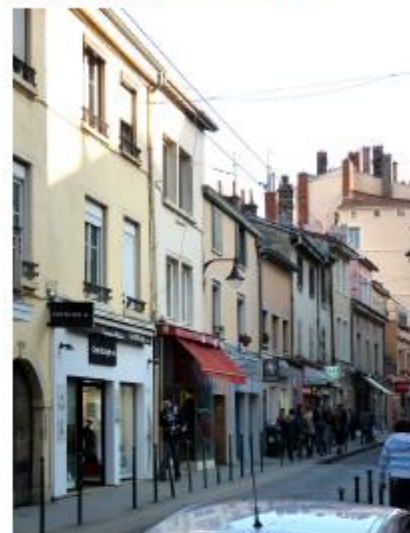
Lyon, quartier de la Croix-Rousse. La plupart des constructions de la rue sont encore en pisé. © Sébastien MORSEZ, CRATERE
