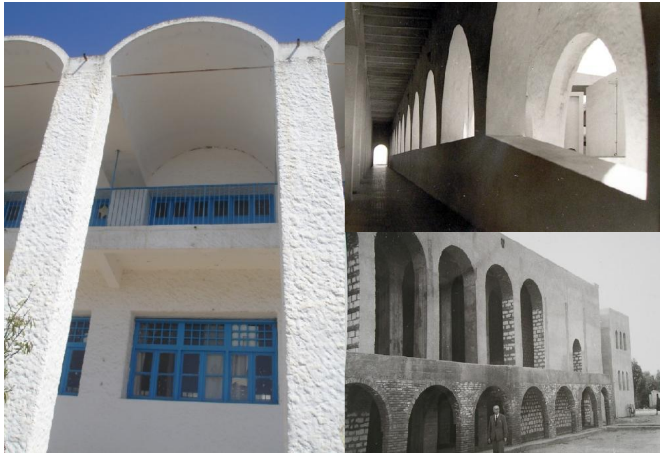
Façade épaisse dans l'architecture de J.Marmey (source: G.JALLALI)
