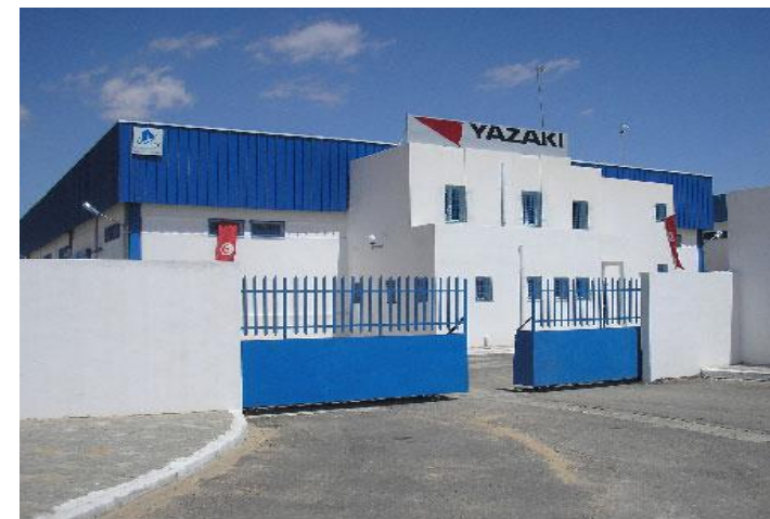
المباني الصناعية بقفصة
